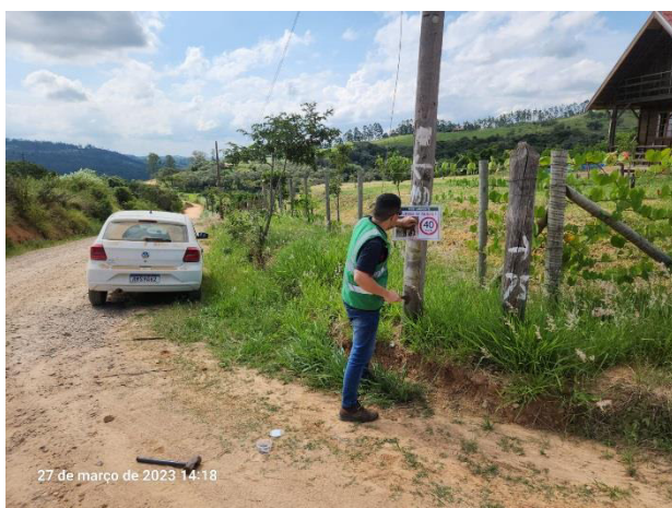
Foto 51 – Durante a manutenção (Data: 27/03/2023).
