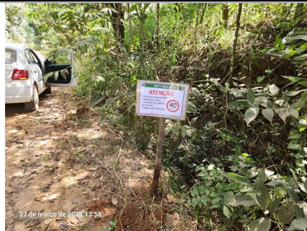
Foto 50 – Após manutenção. (Data: 27/03/2023).
