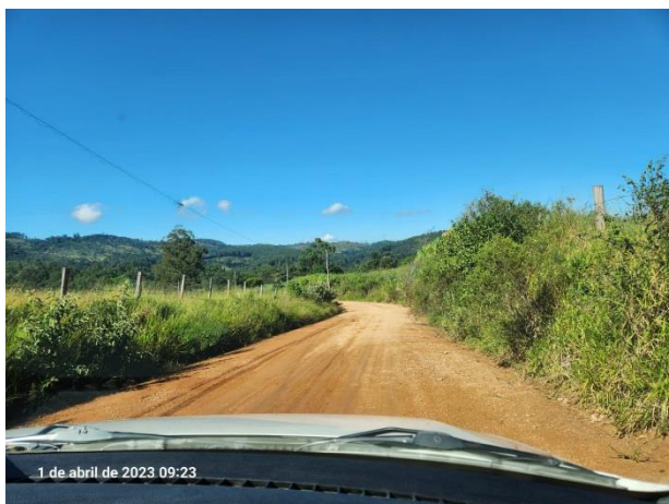
Foto 41 – Percurso percorrido na ADA do empreendimento (Data: 01/04/2023).
